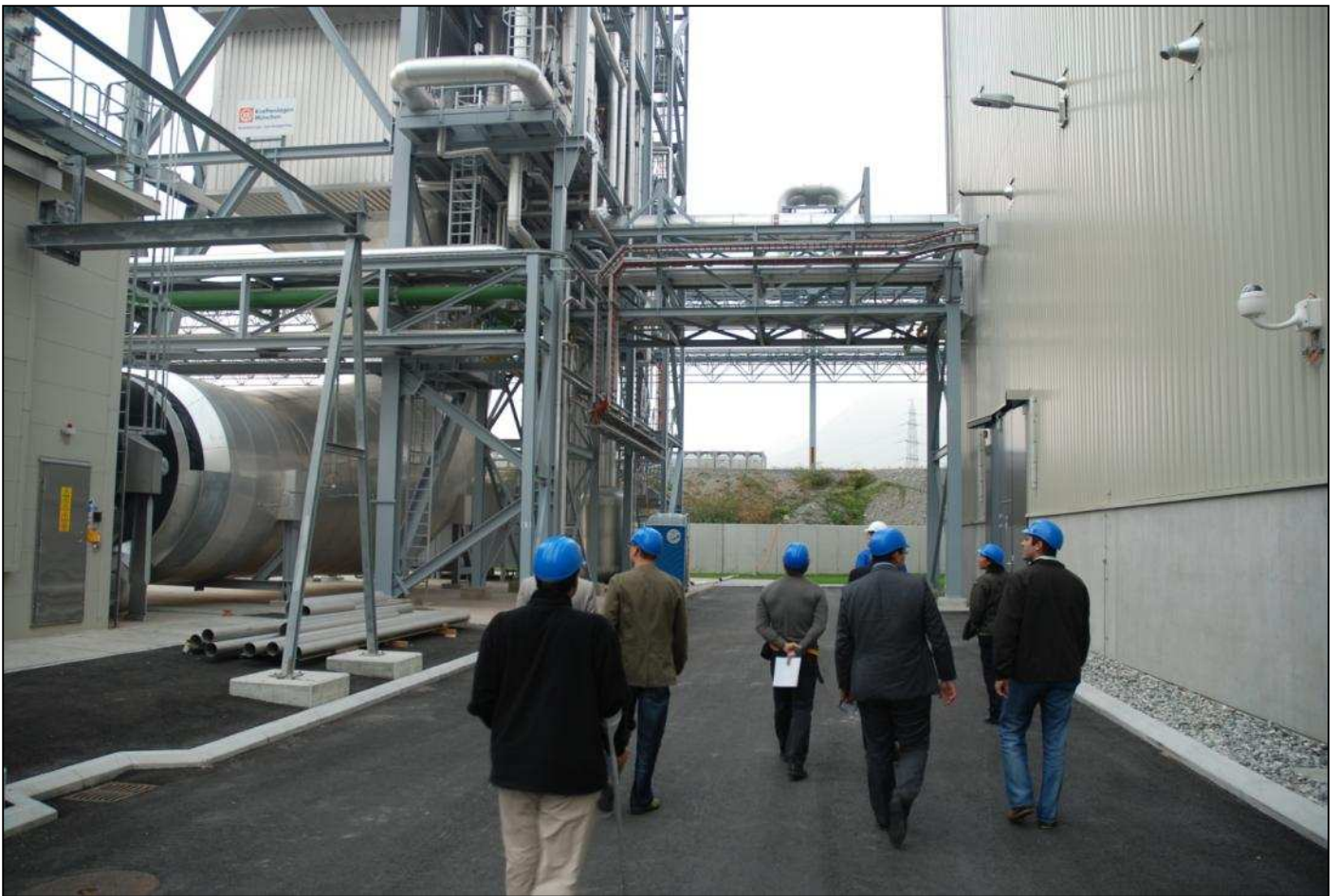
5 à 7 du CREM, 24 septembre 2009 : Centrale à cycle combiné, CIMO, Monthey
